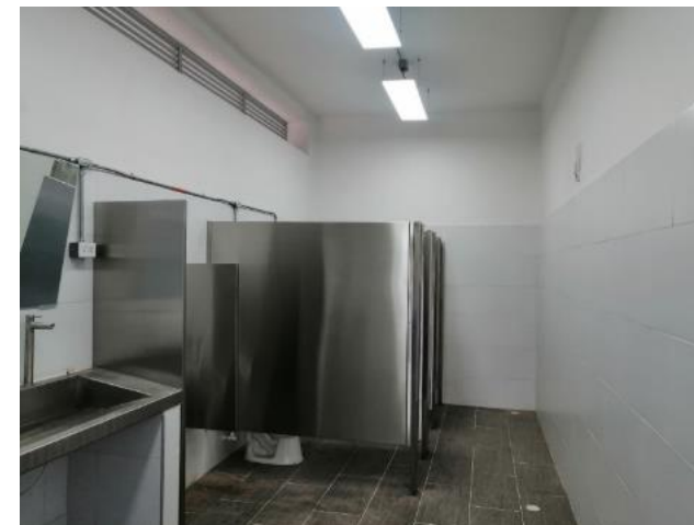
Adecuación y reforma de batería de baños para hombres en el tercer piso de la IE Piloto Simón Bolívar
