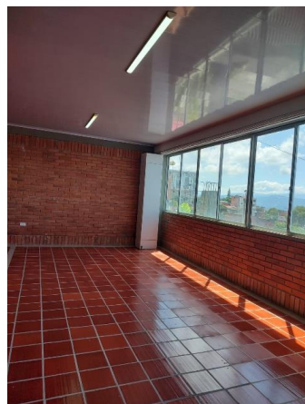
Mejoramiento de la acústica y reubicación de puertas del auditorio y adecuación de espacio sobre vacío de escaleras del tercer piso de la IE Comuneros
