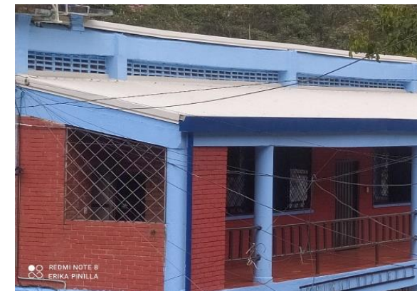
Mantenimiento de cubierta en bloque de aulas de la IE Rural Vijagual Sede A
