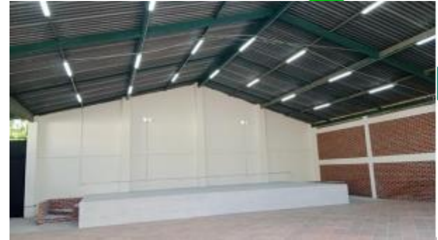
Adecuación de tarima y mejoramiento del aula múltiple de la Institución Educativa Técnico Empresarial José María Estévez
