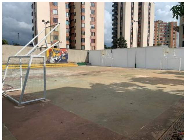
Realizar la adecuación de los espacios deportivos y obras anexas de la IE Nacional de Comercio.
