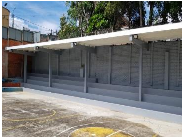
Acondicionamiento de cubierta, gradería e iluminación de la cancha múltiple en la IE Maiporé.
