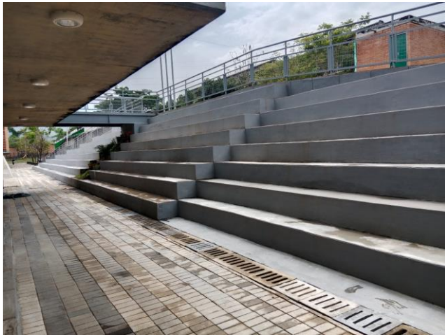
Adecuación de gradería de la cancha deportiva principal de la Institución Educativa Los Colorados
