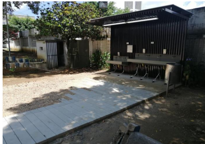
Construcción de lavamanos en la entrada de la institución en la IE Centro Piloto Simón Bolívar.
