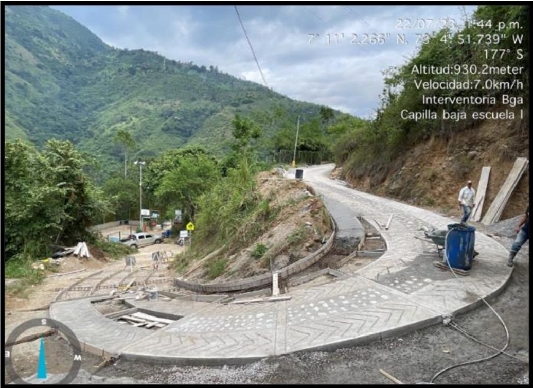
TRAMO VEREDA CAPILLA BAJA – ESCUELA I
