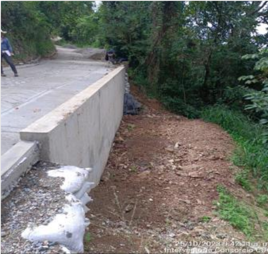
VEREDA BOLOQUI, EL MURO.
